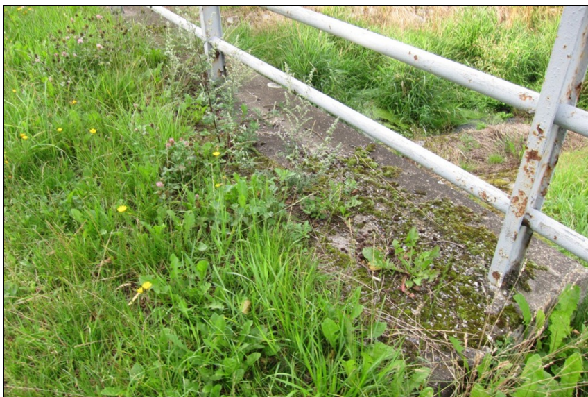
Degradace betonu říms silně zarostlých vegetací.
