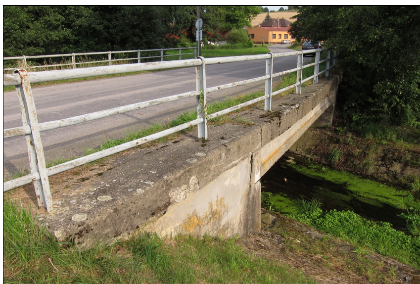
Degradace betonu říms a křídel.
