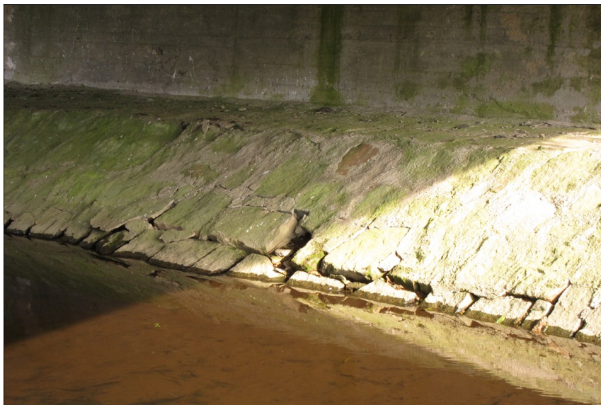
Rozvolněné zpevnění vodoteče pod mostem.
